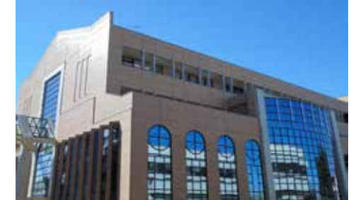
板橋 1F 2F プラザ
